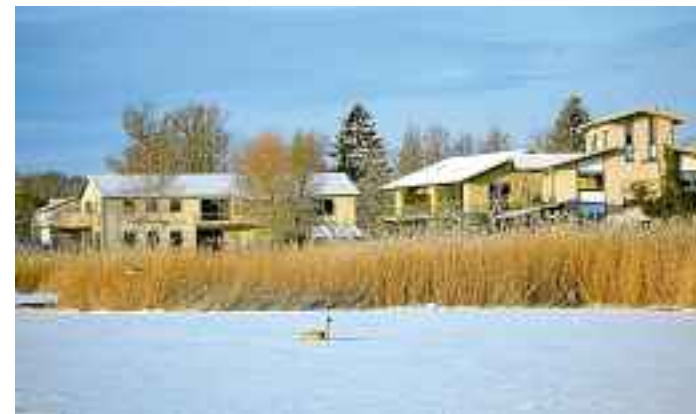
Beschaulich: Die Land-Apartments liegen dicht am Wasser, im Winter friert die Bucht schon mal leicht über. Foto: pd
